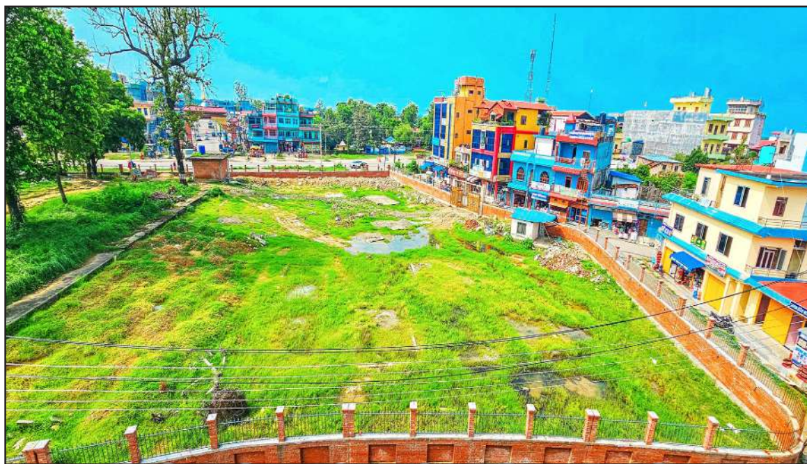
निर्माणाधीन सैनामैना पार्क, सैनामैना-३
