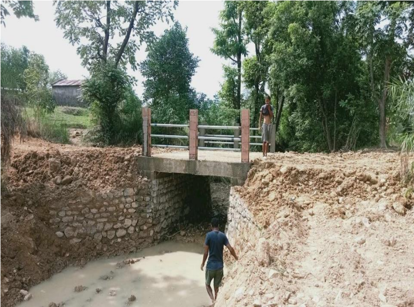
सैनामैना ४ कुँश्मा भाटा टोल कलर्भट निर्माण
