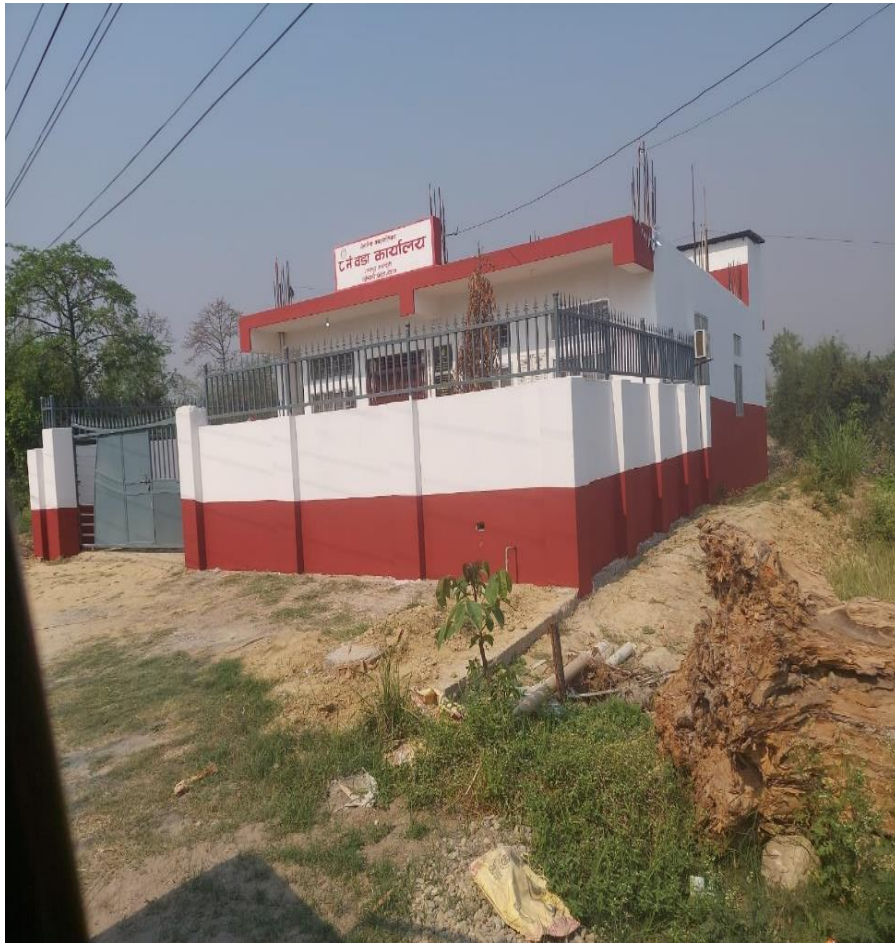
वडा नं. ८ पुर्वाधार निर्माण
