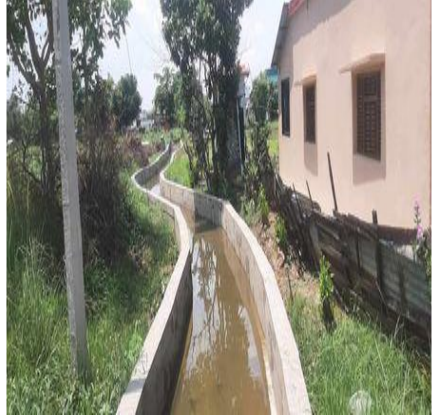
सैनामैना ४ मा कुला निर्माण
