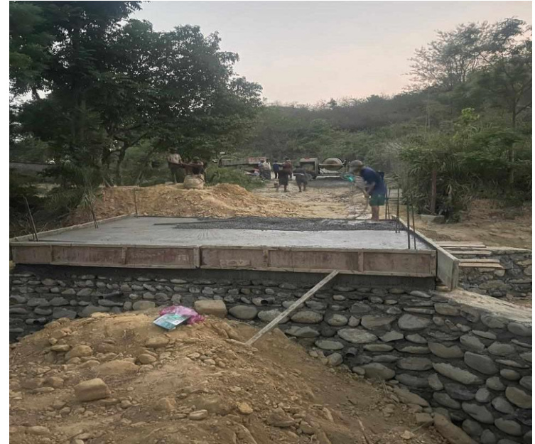
सैनामैना ५ रैरहवा खोलामा कलर्भट निर्माण
