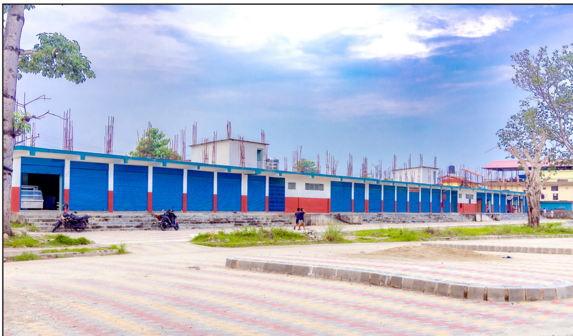
सालभण्डी ढोरपाटन बसपार्क र व्यवसायीक भवन, सैनामैना-१०
